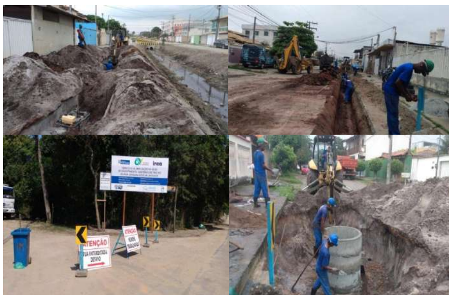
Figura 12- Obras de Extensão de Rede de Esgotamento Sanitário de Rio das Ostras – Rua Joaquim José da Caridade e Loteamento Village. Fonte: CILSJ
